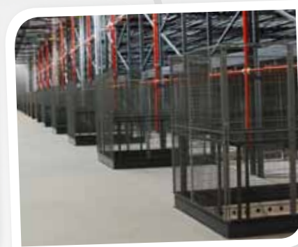
Fahrspuren für Gabelstapler: In Logistikcentern spielt Geschwindigkeit eine große Rolle. Sichere Fahrspuren z.B. für Gabelstapler lassen sich mit dem Caelum-Trennwandsystem sehr einfach darstellen. Für zusätzliche Sicherheit sorgen Türen mit Panikschloss.
