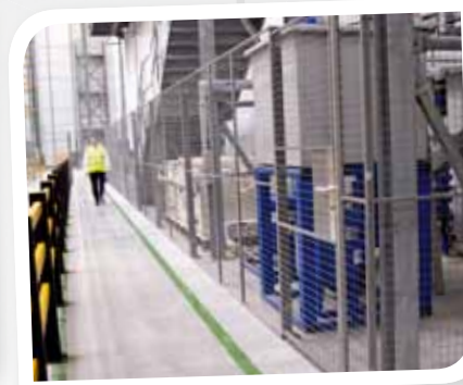
Lagerbereich: Im Lagerbereich setzt Troax Gitterelemente und Vollblechelemente ein. Wenn das Trennwandsystem nicht an der Decke der Lagerhalle anschließt, empfehlen wir einen 'Über-Kopf-Schutz' aus Gitterelementen.
